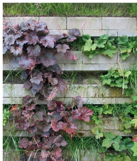
Vertikale Begrünung: Modulsystem auf Basis von mineralischen Bauelementen.
