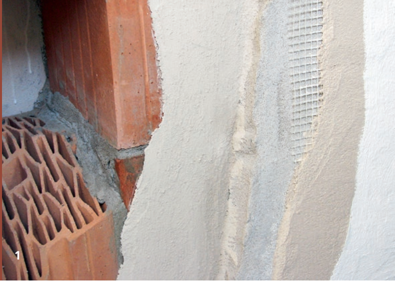
1 Schematischer Fassadenaufbau aus Hochlochziegeln (HLZ) mit mineralischem Wärmedämmputz.
