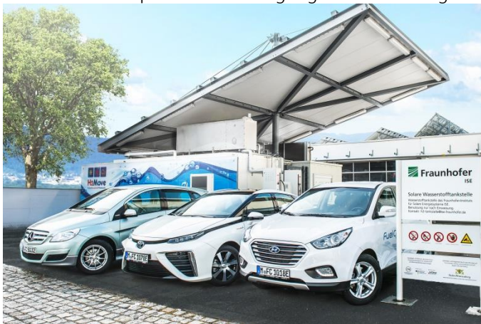
Die mit Solarstrom betriebene H 2 -Tankstelle des Fraunhofer ISE. ©Fraunhofer ISE
