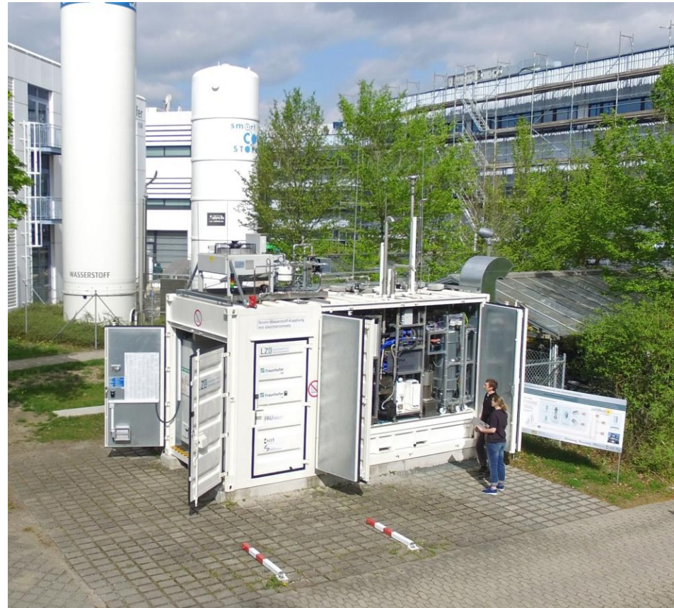
LOHC-Container am Fraunhofer IISB in Erlangen Bild: Kurt Fuchs / Fraunhofer IISB
