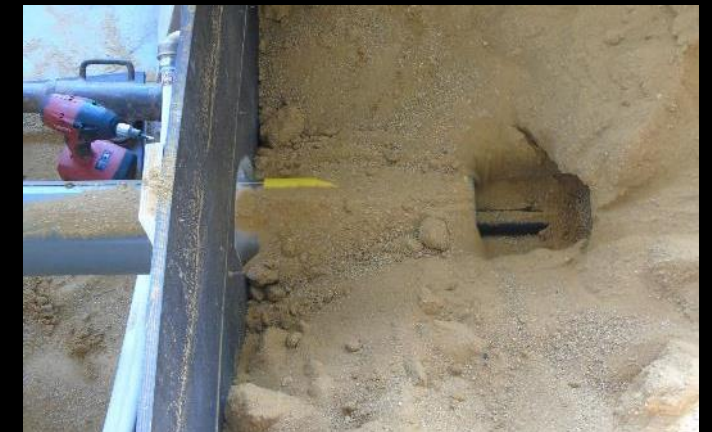
Eingebaute Erdwärmesonde
