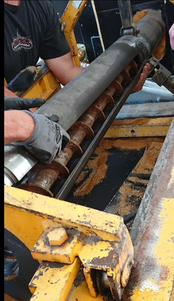
Einbau geteiltes Bohrgestänge
