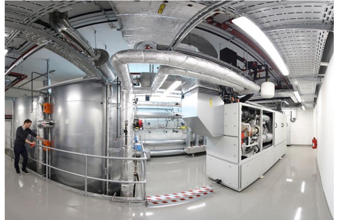
© Kurt Fuchs / Fraunhofer IISB. KWK-Anlage am Fraunhofer IISB Wärmespeicher (links) und BHKW (rechts)
