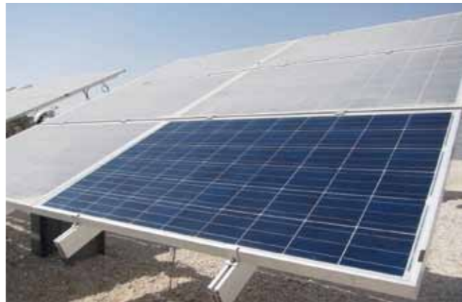
Die Verschmutzung von Solarmodulen mit Sand und Staub mindert die Erträge in Wüstenregionen.
